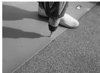
穿孔、プラグレスアンカーによりポリフィン防水シートを固定
