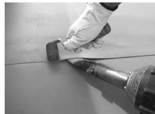
熱風を当て、シートを溶かして溶着する
